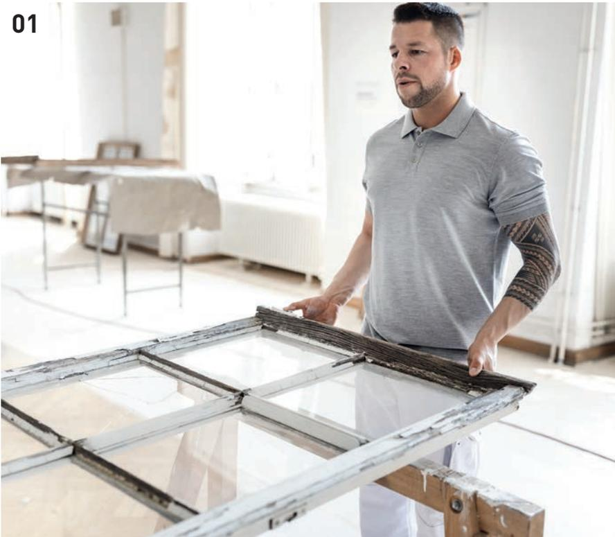
Ist-Zustand des Fensters begutachten (ausgehängt, liegend): Schadstellen identifizieren. Nicht intakte Altbeschichtungen und lose Holzteile müssen entfernt werden. Ggf. zur Beurteilung grob abschleifen.
