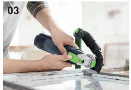
Fensterscheibe bei Bedarf sorgfältig herauslösen. Vollständiges Entfernen des Fenster-Kitts mit Akku-Oszillierer VECTURO und StarlockMax Segmentsägeblatt.
