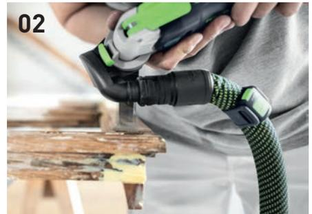
Entfernen von nicht tragfähigem, verfaultem Holz mit Akku-Oszillierer VECTURO und Starlock Universalsägeblatt.
