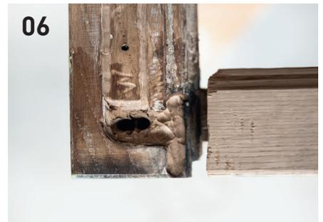
Zustandsprüfung der zu bearbeitenden Stelle nach dem Abtrag der Altbeschichtung und des schadhaften Materials.
