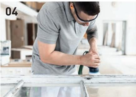
Altbeschichtung an der Schadstelle mit ROTEX RO 90 entfernen: Einstellung auf GROB für großen Abtrag. Je nach Zustand des Untergrundes Granat Schleifmittel P60-P100 verwenden.
