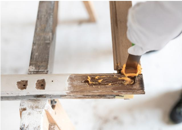
Anwendungs-Tipp: Vor dem vollständigen Füllen, die Oberfläche vorher dünn benetzen, um eine bessere Haftung für die DRY FLEX®-Masse zu erreichen.
