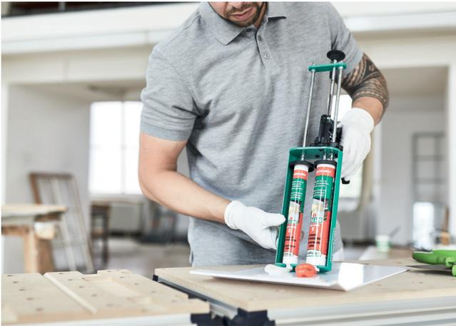
Je nach Anwendungsfall die richtige 2-Komponenten Holzergänzungsmasse wählen (Anwendungsschema Repair Care auf Folgeseite). Zur besseren Mischkontrolle DRY FLEX® Masse auf einer hellen, glatten Oberfläche mit dem Spachtel anmischen.
