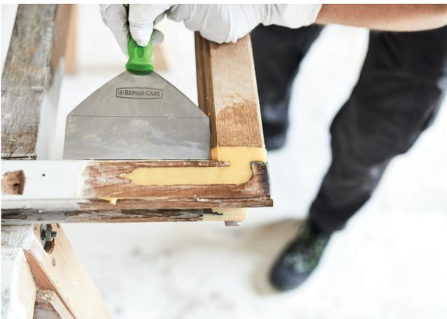
Die Reparaturstelle mit Holzergänzungsmasse DRY FLEX® spachteln und an der Schadstelle glatt ziehen; besonders darauf achten, dass die Vertiefungen ohne Lufteinschlüsse komplett geschlossen sind.
