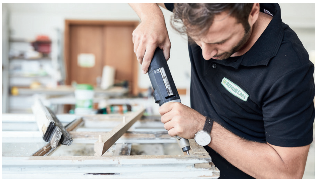
Holzschäden ausfräsen
